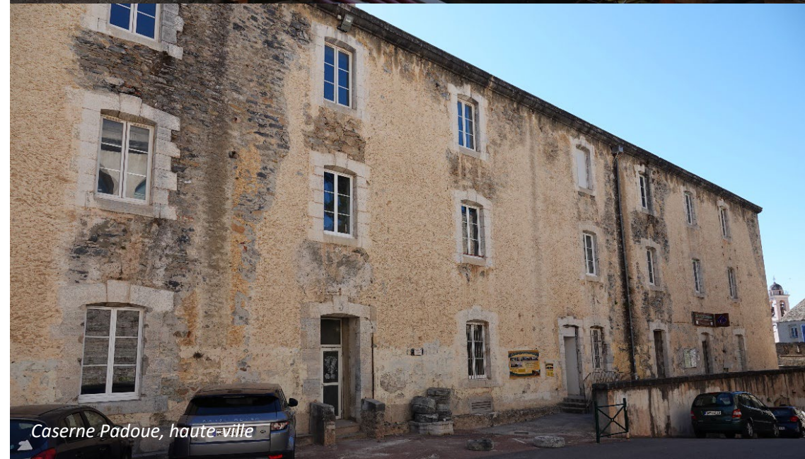
Réhabilitation en cours du bâtiment Robert Alberti, campus Mariani
