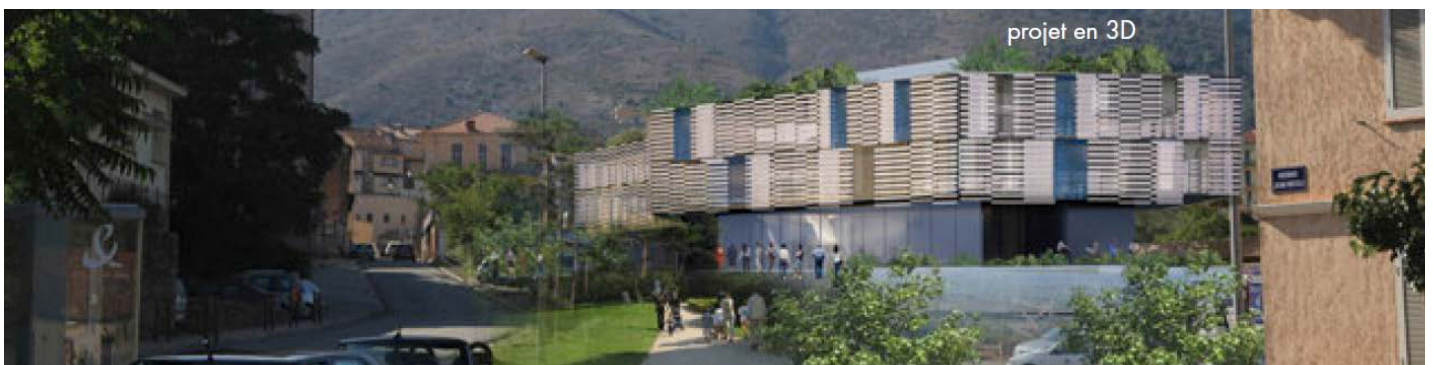
Mise en situation, en 3D, du nouveau bâtiment de recherche en sciences humaines et sociales de l'Université de Corse prévu pour 2016.
