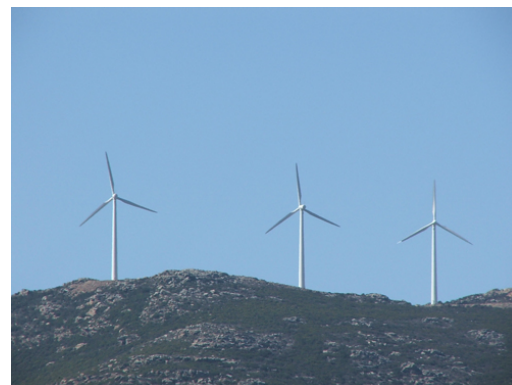
Parc éolien du cap Corse
